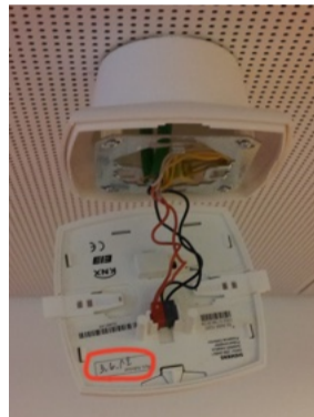
Abbildung 22: Konfigurationsdaten einfach zugänglich auf dem Gerät
