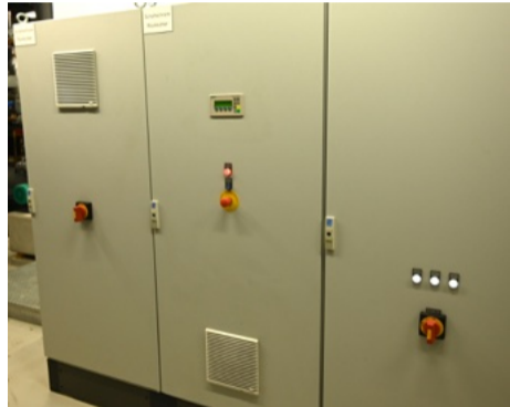
Abbildung 33: Diverse Not-Aus-Schalter
