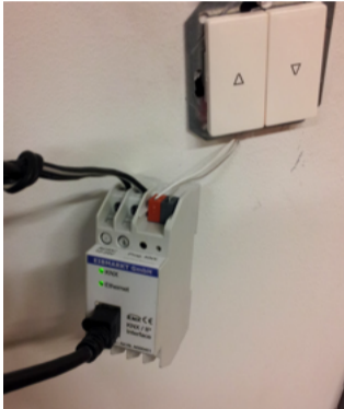
Abbildung 19: Zugang zu Feldebene via Gateway
