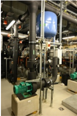
Abbildung 29: Kältepumpe
