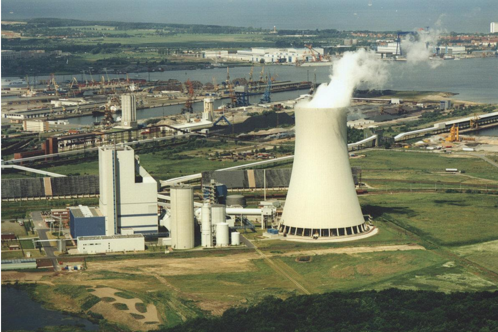
Kraftwerk Rostock Feuerungswärme 1370 MW Elektrische Leistung 514 MW
